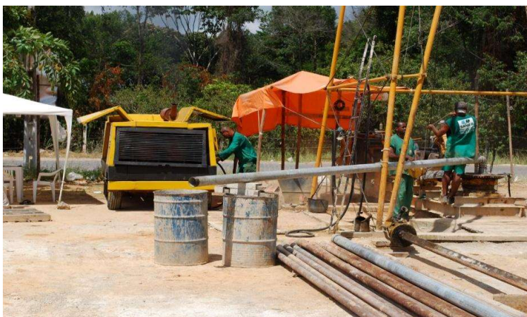
Figura 5 – Perfuração Poço de Água de Abreu e Lima/PE
